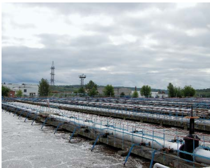
Очистные сооружения канализации г. Калуги
