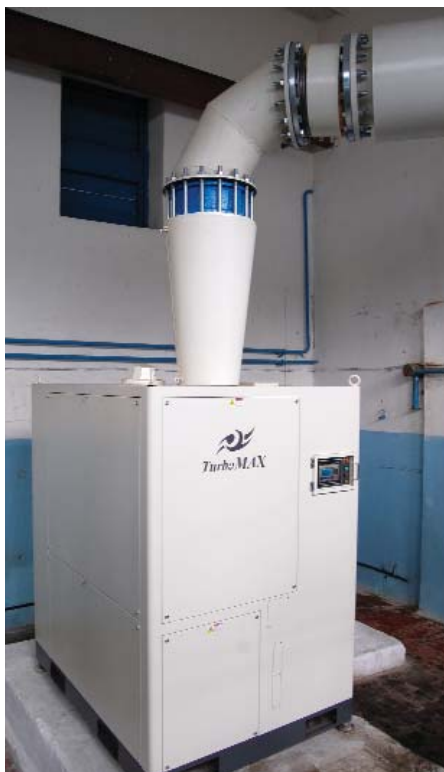
Воздуходувка марки TurboMAX (производство Корея)
